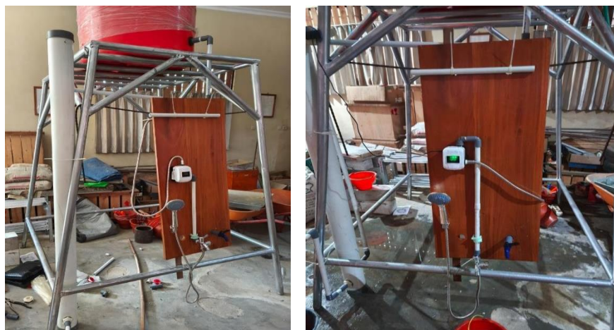
Gambar 3. Instalasi alat dan pengujian serta aktifasi semua komponen untuk uji coba
