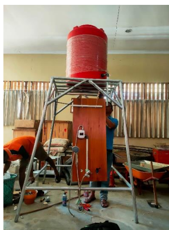
Gambar 3. Tower air untuk tandon dengan tinggi 2 meter
