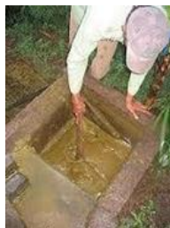
Gambar 10. Pembuatan Bak Penampungan Kotoran
