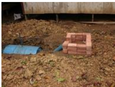
Gambar 8. Proses penggalian lubang digester/reaktor
