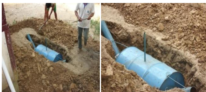
Gambar 9. Proses pemasukan digester ke dalam lubang galian
