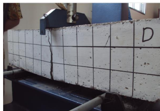
Gambar 10. Keruntuhan Lentur Balok (Layang &amp; Wiratno, 2013)
