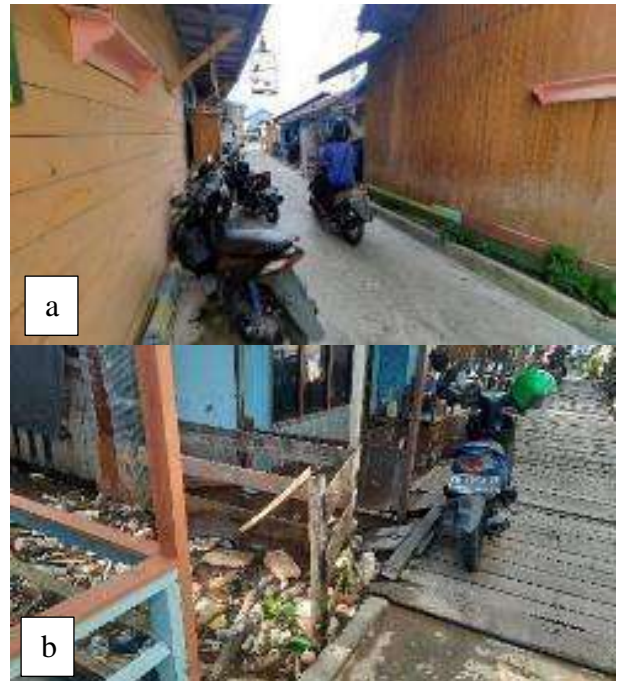
Gambar 6. Jalan Cor Beton (a) dan Jalan Titian Kayu (b) (Sumber: Dokumentasi Peneliti, 2024)
