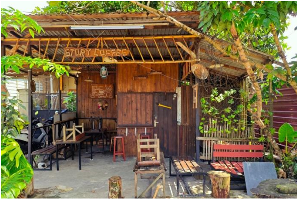
Gambar 2. Bangunan Kafe Semi-terbuka
