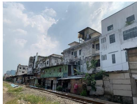
Gambar 1. Keadaan struktur bangunan pemukiman kumuh Glugur II
