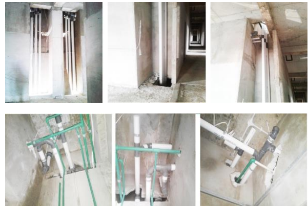
Gambar 11. Sistem plumbing dan shaft basah
