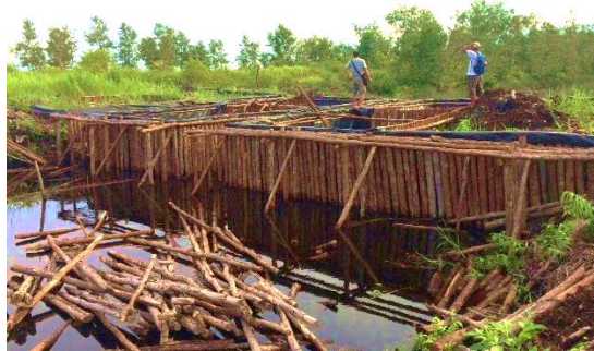
Gambar 34. Kondisi saluran dan konstruksi sekat di lokasi penelitian (Sumber: dokumen survei, 2017)
