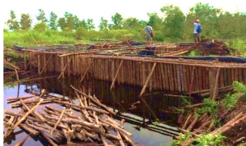
Gambar 28. Kondisi saluran dan konstruksi sekat di lokasi penelitian (Sumber: dokumen survei, 2017)
