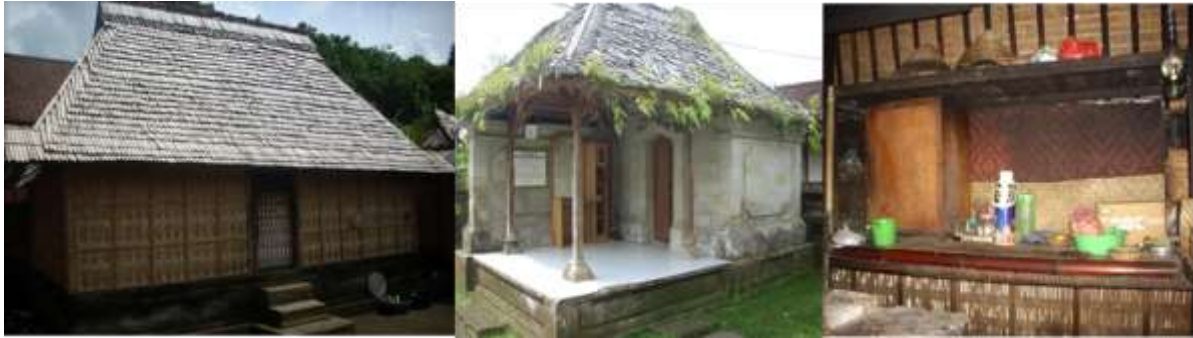
Gambar 5 Pemakaian bahan lokal sebagai bahan bangunan Sumber : Penulis, 2022
