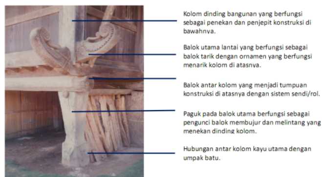
Gambar 36. Sistem Tumpu, Jepit, Tekan dan Tarik Pada Lamban Tuha Kenali
