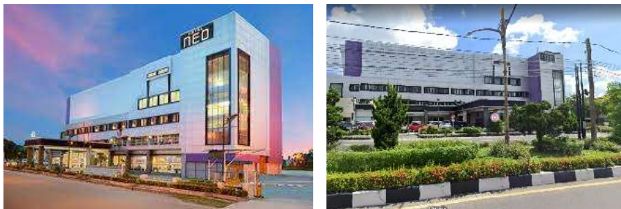
Gambar 2. Foto Lingkungan Hotel Neo (Sumber: Dokumentasi, 2023)
