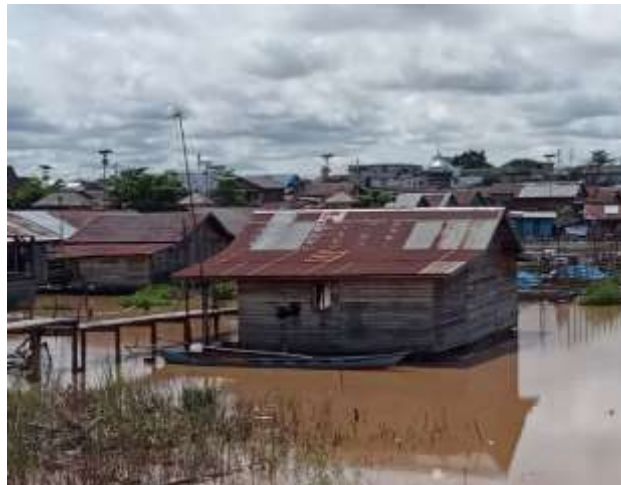
Gambar 3. Rumah di atas sungai Sumber: Dokumentasi Pribadi
