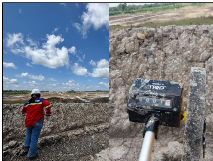
Gambar 4. Pengukuran Tinggi Safety Berm Pada Tanjakan Bengkirai
