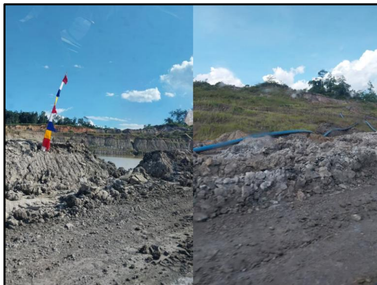
Gambar 5. Kondisi Sistem Drainase dan Penyaliran Area Tambang
