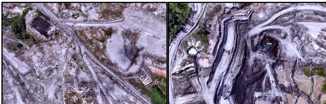
Gambar 7. Kondisi Tikungan dan Persimpangan Jalan Tambang: (a) Jalan Disposal Meranti dan (b) Pertigaan Jalan Pit Tora
