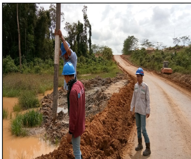
Gambar 7. Pemasangan Lampu Penerangan Jalan Tambang (Sumber : Dok. Lapangan, 2021)
