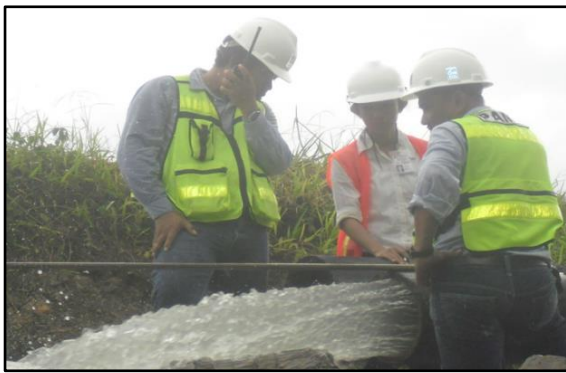
Gambar 2. Pengukuran Outlet Pompa Multiflo 420 dengan Metode Discharge
