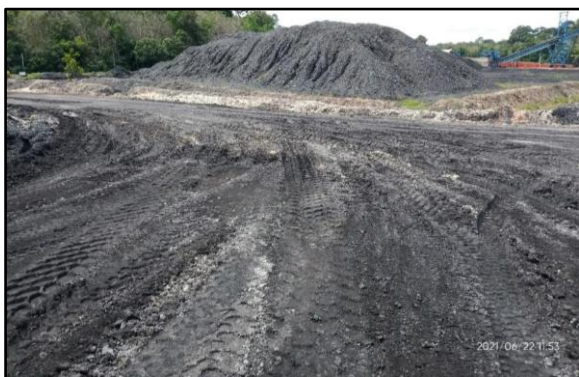
Gambar 3. Kondisi Jalan Angkut
