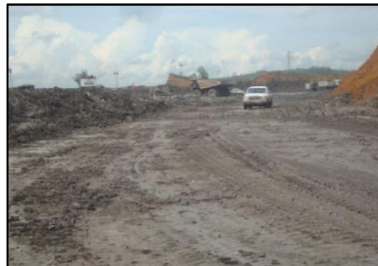
Gambar 3. Kondisi jalan licin
