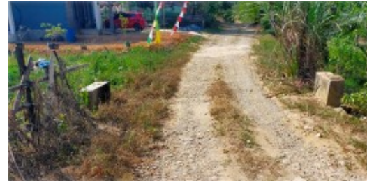
Gambar 3. Existing Tipikal Jembatan
