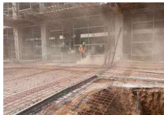
Gambar 3. Proses Area Pembersihan Pengecoran Pelat Lantai Konvensional
