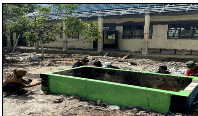
Gambar 4. Pengecatan kolam
