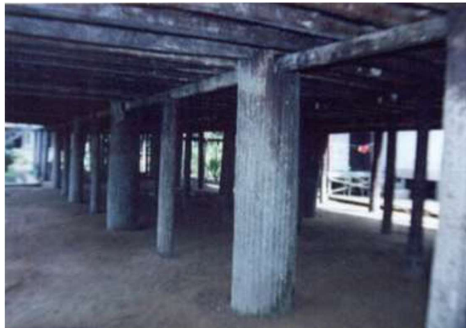
Gambar 3. Material bangunan yaitu tiang utama dari kayu ulin (Dokumentasi, 2022)
