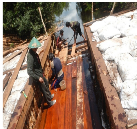
Gambar 1 Kegiatan pembangunan sekat kanal
