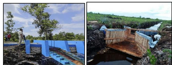
Gambar 5. Sekat kanal yang dibangun sebagai bagian restorasi hidrologi
