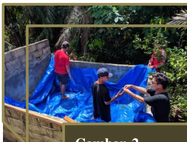
Gambar 2. Pemasangan terpal pada kolam
