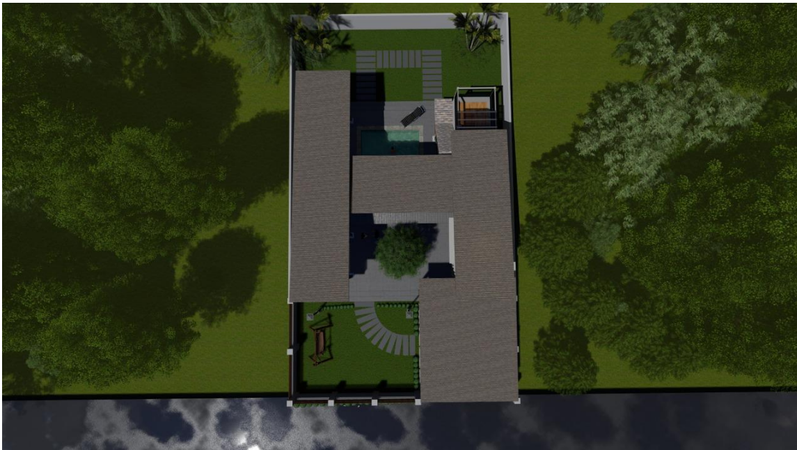
Gambar 4. Tampak dari atas bangunan hunian Kontainer
