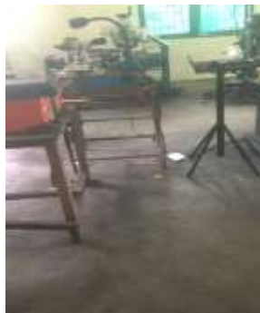
Gambar 4. Kondisi Lantai Semen
